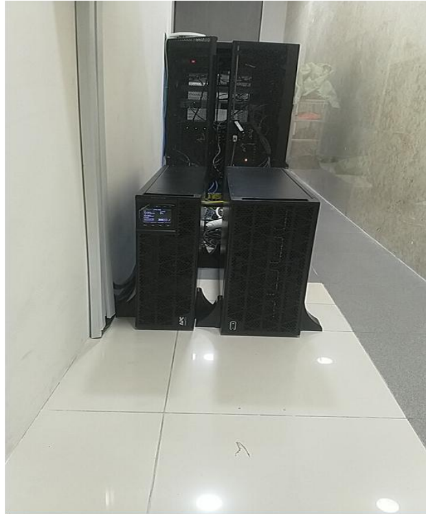
Pemasangan UPS untuk Perangkat Ruang NOC
