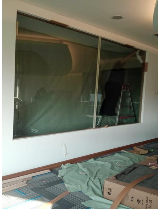
Pekerjaan Smart Glass Ruang NOC
