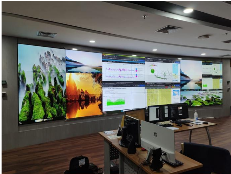
Pemasangan Video Wall di Kanan dan Kiri
