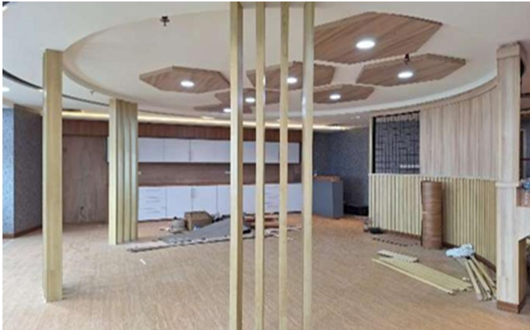
Pekerjaan Ruang Breakout Room
