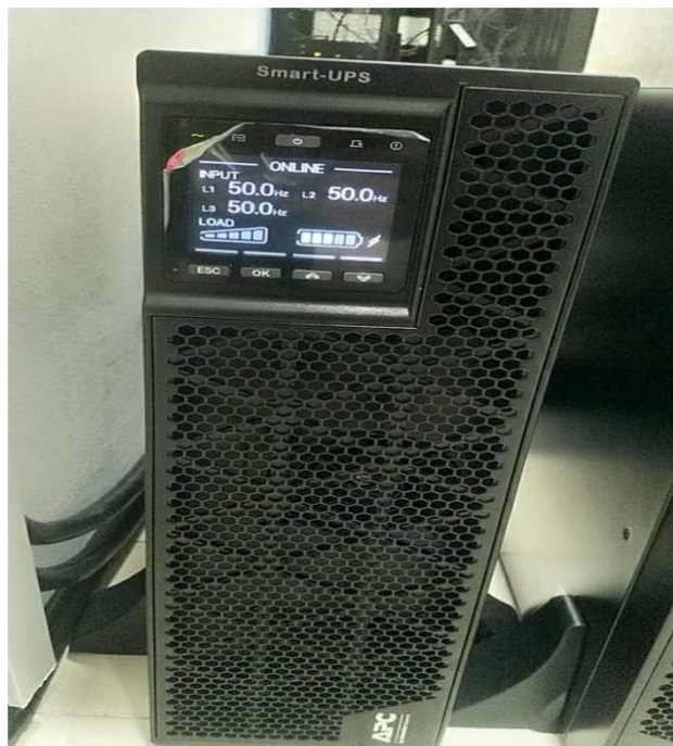
Pemasangan UPS untuk Perangkat Ruang NOC
